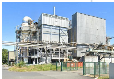
Façade sud de l'usine actuelle
